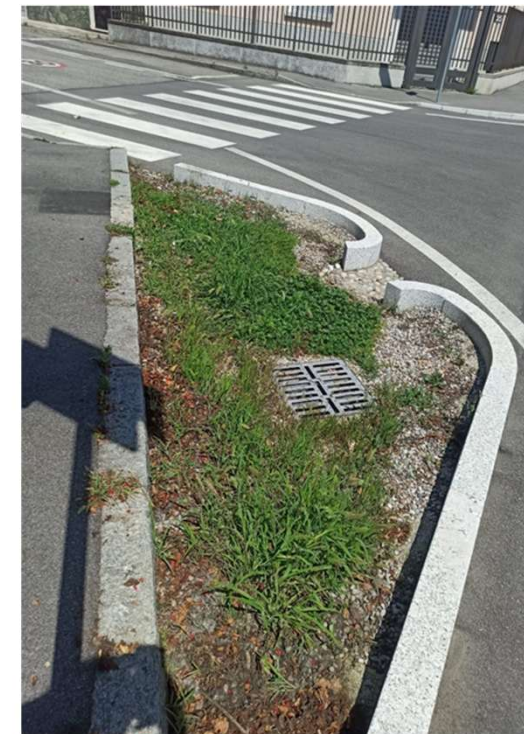
Un'altra trincea drenante
