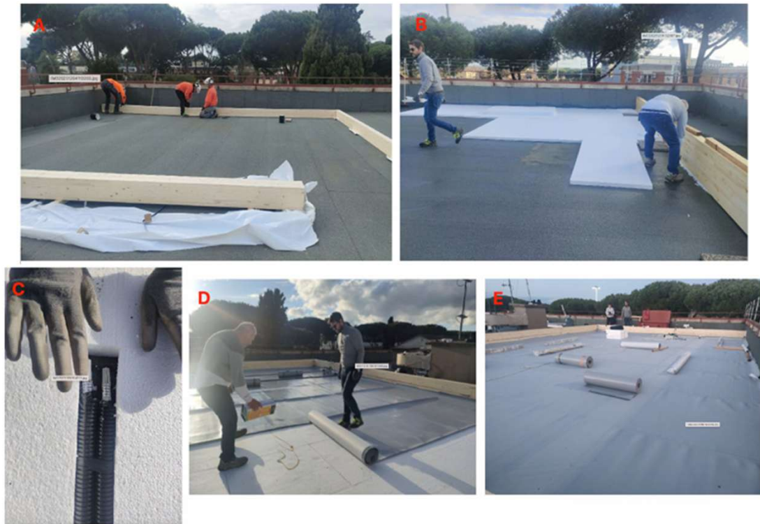
Figura 10. Fotografie sul tetto durante il cantiere per l'installazione del sistema BGR. A) Posa in opera delle travi a costituire il profilo di contenimento per delimitare la superficie del campo prova; B) posa in opera dei pannelli pendenzati; C) particolare del posizionamento della coppia di sensori di contatto per la misura della temperatura superficiale del lastrico solare, sotto manto, a livello della parcella P4; D) e E) posa in opera della guaina.
