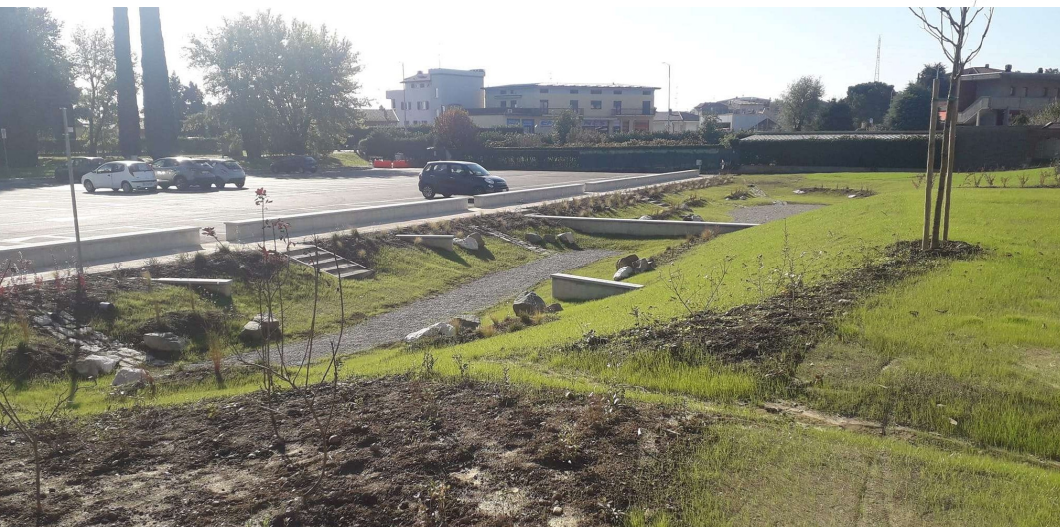
Fotografia del bacino di ritenzione appena realizzato (novembre 2024)
