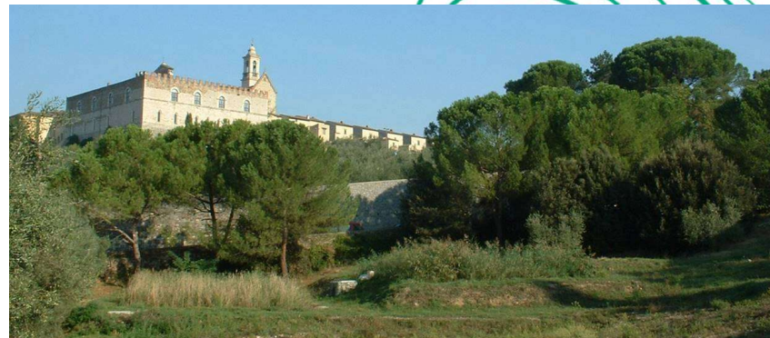
zona umida artificiale a flusso subsuperficiale al servizio dell'Hotel Certosa, vicino Firenze
