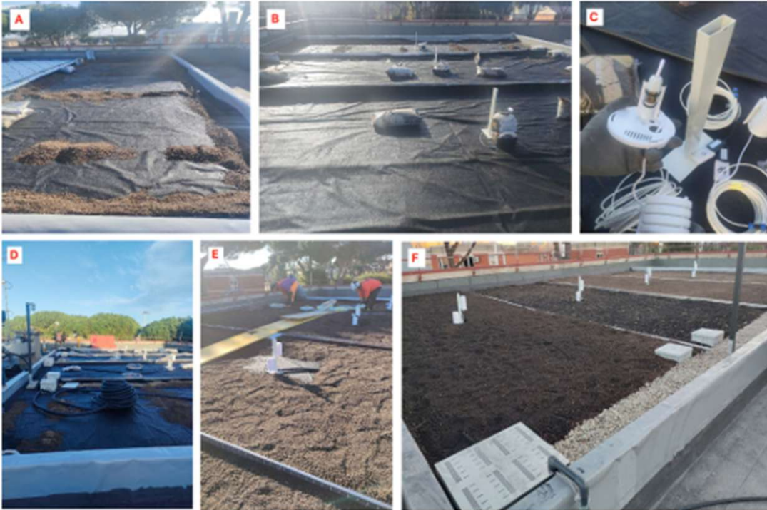
Figura 12 - Fotografie sul tetto durante il cantiere per l'installazione del sistema BGR. A) Applicazione del filtro in geotessuto (tessuto non tessuto) come strato di separazione tra il pannello ed il substrato. Il geotessuto, oltre ad impedire a piccoli frammenti di terriccio di penetrare nella stratigrafia sottostante, assorbe e trattiene sia l'acqua piovana che l'acqua d'irrigazione proveniente dal bacino secondario. B) Il geotessuto viene disposto sulle 4 parcelle del campo prova; in seguito, al centro di ogni parcella, viene collocata una colonnina metallica per l'ancoraggio della sensoristica (temperatura e umidità del suolo e dell'aria, ovvero T1, U1, T2, U2, T3, U3, T4, U4; vedi Fig. 31). C) Particolare della sensoristica, sono visibili le custodie protettive dei sensori per la temperatura e umidità dell'aria e i due sensori per la temperatura e umidità del suolo con la sonda ancora coperta, che andranno collocati a diverse altezze a partire dalla base di geotessuto. D) Le videocamere sono state posizionate, una a cavallo delle parcelle P1 e P2, l'altra a cavallo delle parcelle P3 e P4; attraverso i tubi corrugati neri verranno fatti passare i cavi elettrici di collegamento con la centralina del sistema e alla presa elettrica. E) Aggiunta del substrato posato sopra il geotessuto; F) il substrato è stato posato nello spessore stabilito (8 cm per il Sedum in P2 e P4; 12 cm per il prato fiorito in P1 e P3) e miscelato al Biochar in P1 e P3; in P2 e P4 il Sedum è stato già messo a dimora per spargimento di talee.
